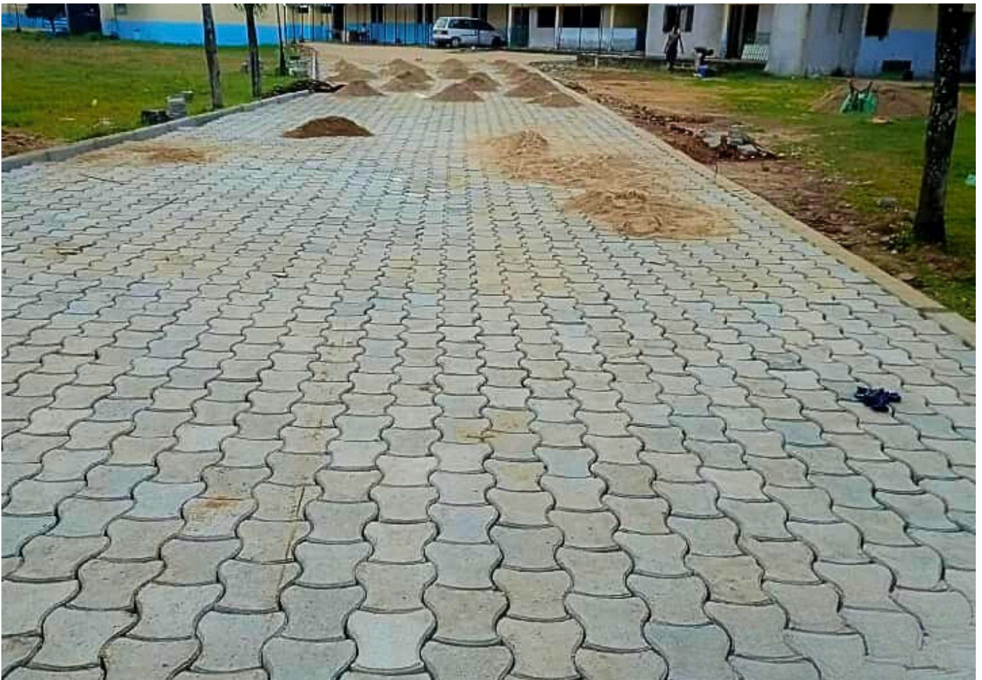
mise en pavé à l'école supérieur ENS
