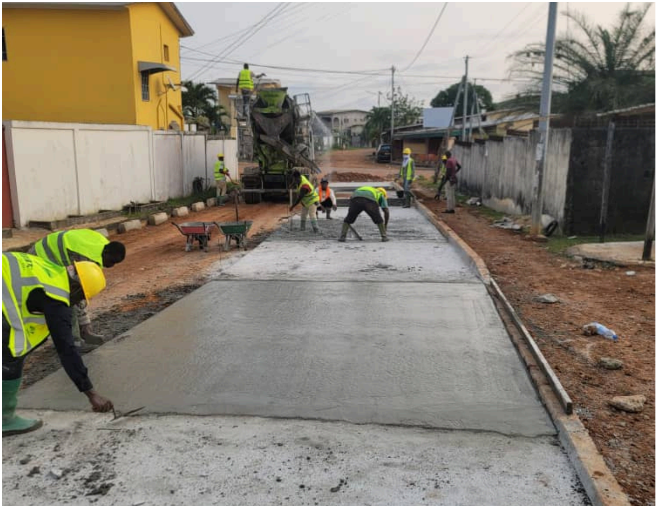
Travaux routiers à akanda, 4 ème cité
